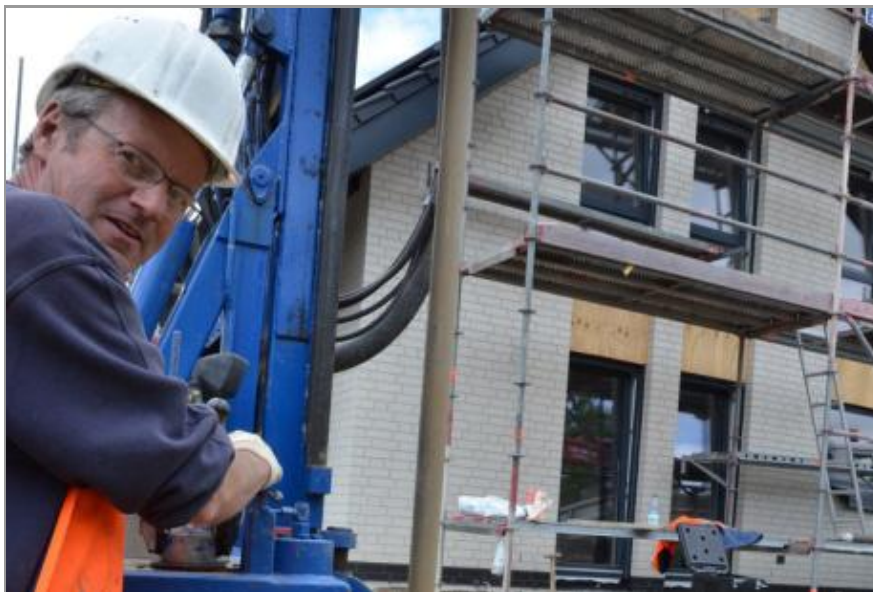
Torsten Kühn, Bohrmeister und Projektleiter der Firma Sven Hansen Wasser- und Brunnenbautechnik, bohrt ein Loch für Erdwärmesonden Foto: Lars Koch
