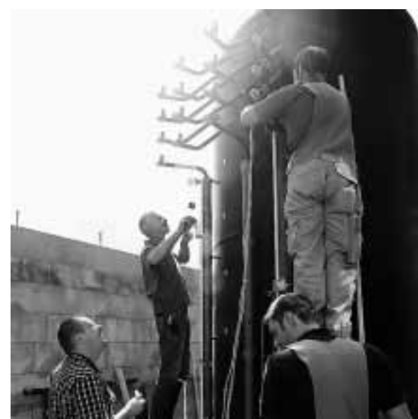
11,8 Kubikmeter Wasser fasst der Wärmespeicher, der von Solarkollektoren und dem Kamin gespeist wird.
