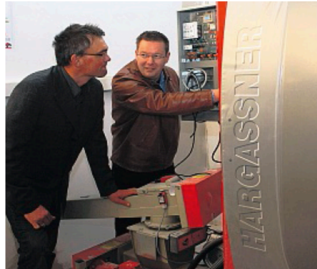
Peter Rausch (Hotel Wattenkieker, l.) lässt sich von Dipl.-Ing. Ingo Stöver die Steuerung des neuen Holzsnitzel-Heizkessels erklären. Foto: Koppe
